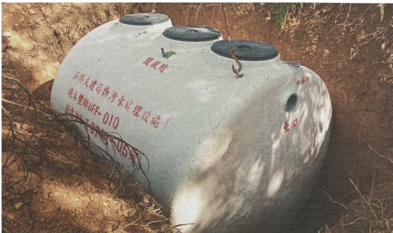
施工中主槽體定置
