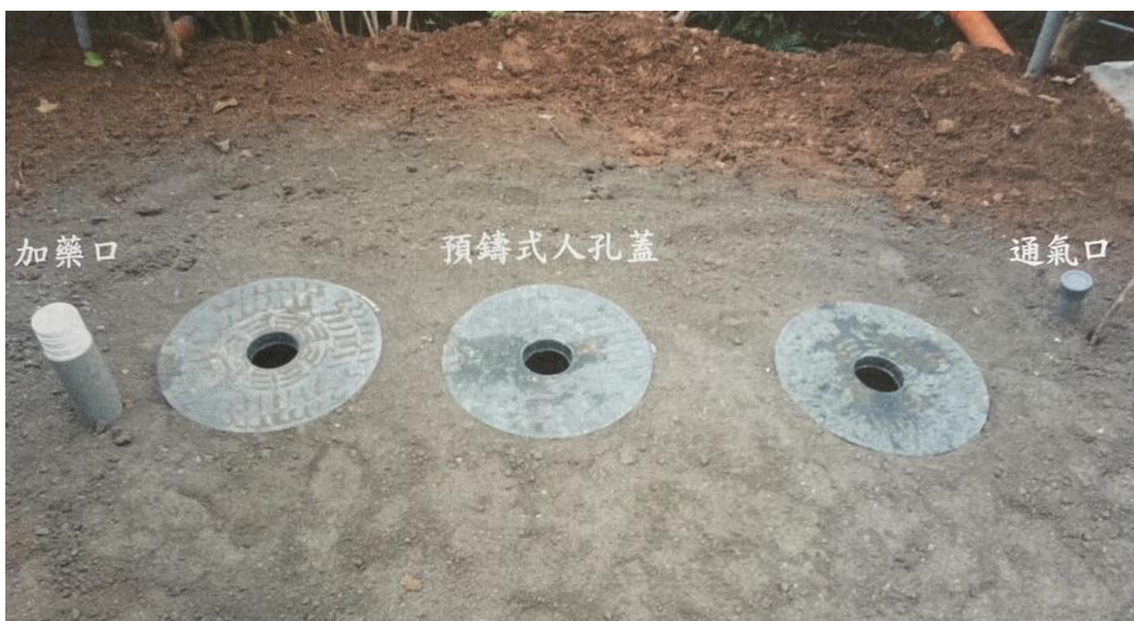
施工後設置 3 組預鑄式 PE 蓋
