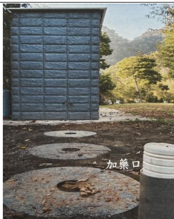
施工後設置通氣口及加藥口
