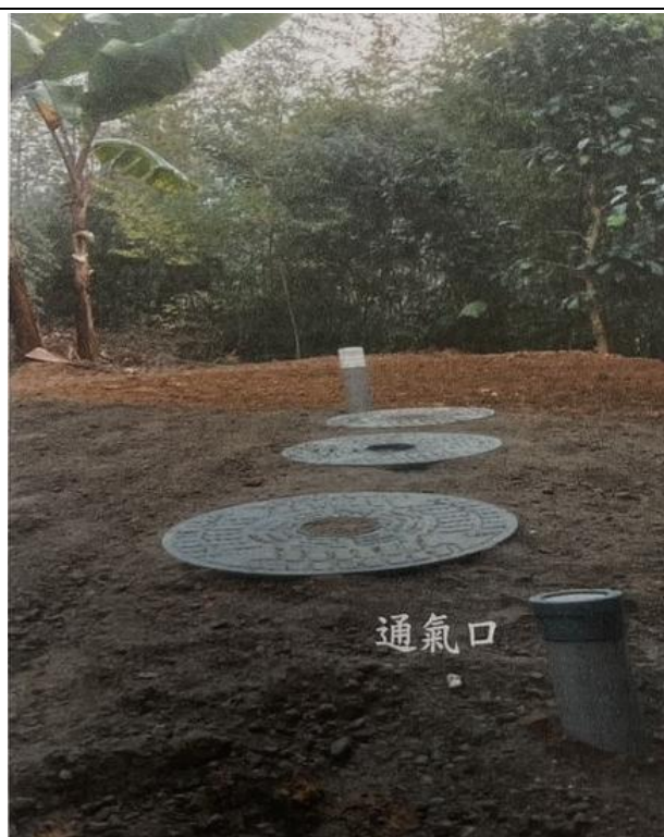
施工後設置通氣口及加藥口
