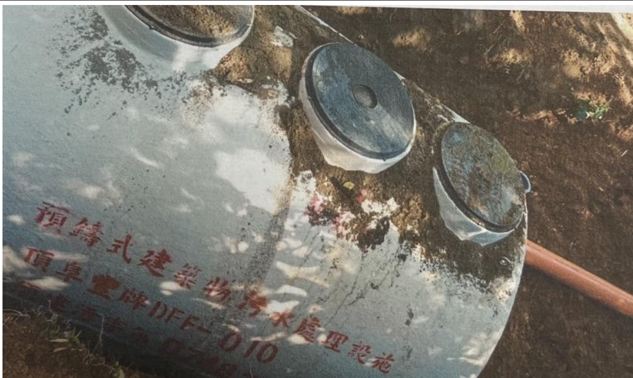
施工中主槽體人工填土及接管
