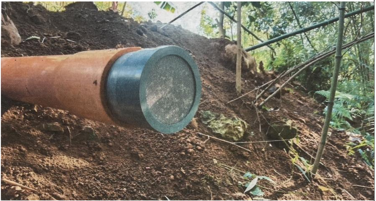
完工後 放流口設置防蟲網蓋
