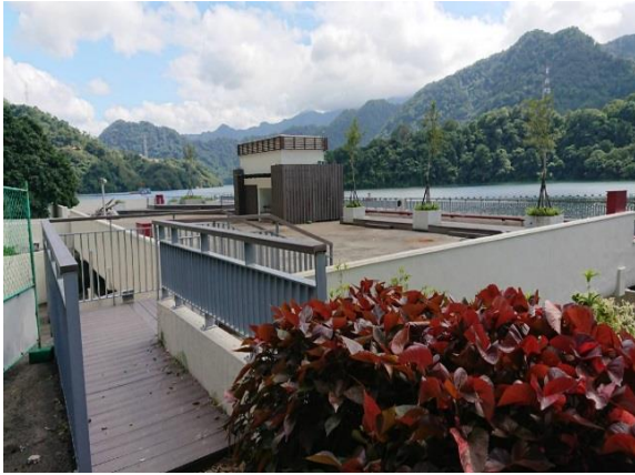
圖 5 運動休憩點-壩頂休憩站完工
