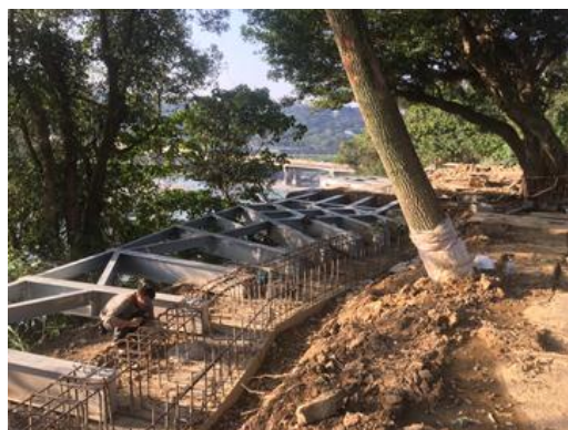
崖線步道整建施工
