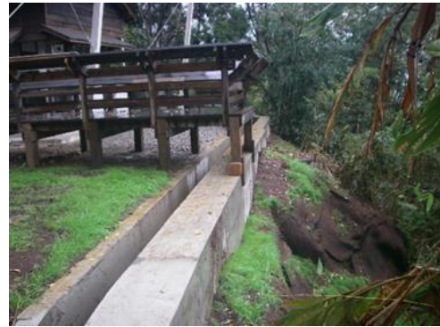
邊坡災害復建後景況
